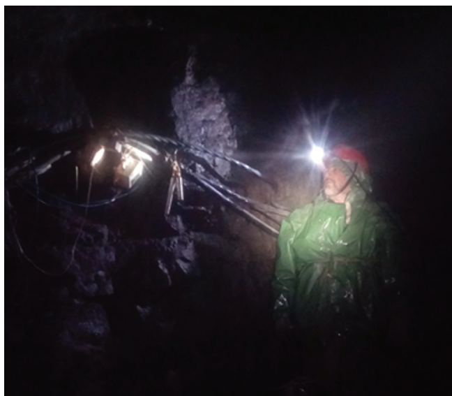
Рис. 4. Узел сети с газовыми датчиками в шахте
