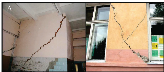
Рис. 1. Последствия стихийных бедствий в Байкальском регионе: А – трещины в стенах здания школы поселка Култук Иркутской области в результате Култукского землетрясения 27 августа 2008 г. (фото с сайта http://www.yablor.ru ); В – разрушения зданий и наносы грубообломочного материала в поселке Аршан Республики Бурятия в результате схода селя 28 июня 2014 г. (фото с сайта http://www.irk.aif.ru )
