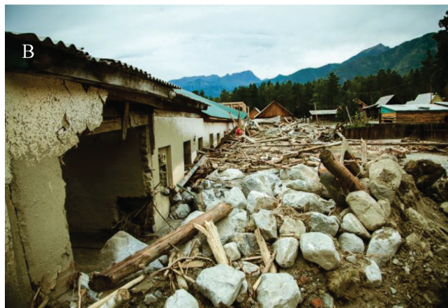
Рис. 1. Последствия стихийных бедствий в Байкальском регионе: А – трещины в стенах здания школы поселка Култук Иркутской области в результате Култукского землетрясения 27 августа 2008 г. (фото с сайта http://www.yablor.ru ); В – разрушения зданий и наносы грубообломочного материала в поселке Аршан Республики Бурятия в результате схода селя 28 июня 2014 г. (фото с сайта http://www.irk.aif.ru )
